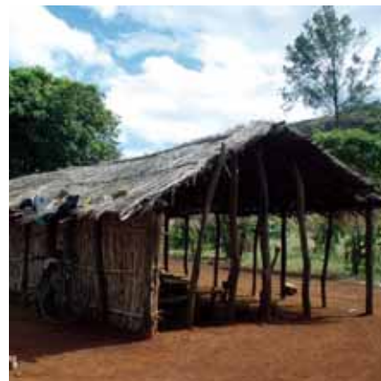
Projecto “Mais Moçambique Pra Mim”. Escola antes do início das obras
