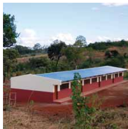
Projecto “Mais Moçambique Pra Mim”. Escola após reconstrução
