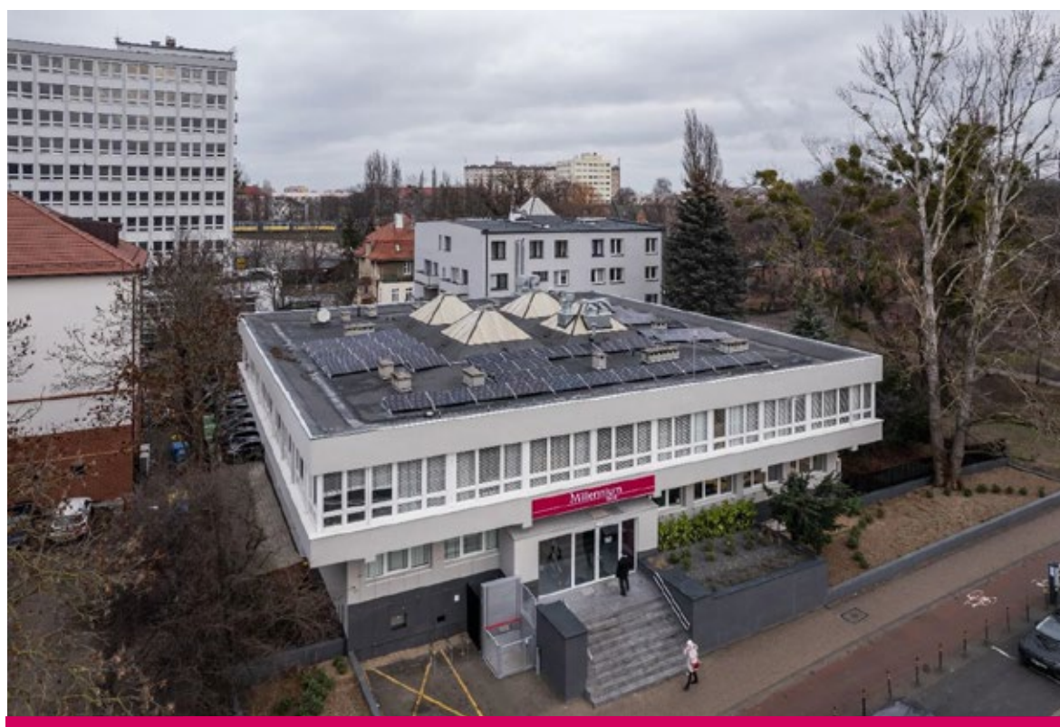
Central fotovoltaica - serviços centrais em Gdansk (Polónia)
