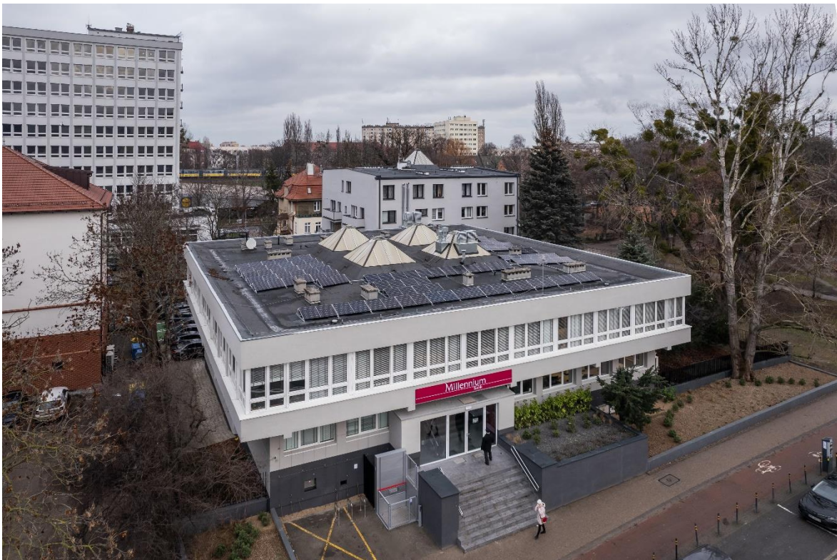
Central fotovoltaica - serviços centrais em Gdansk (Polónia)
